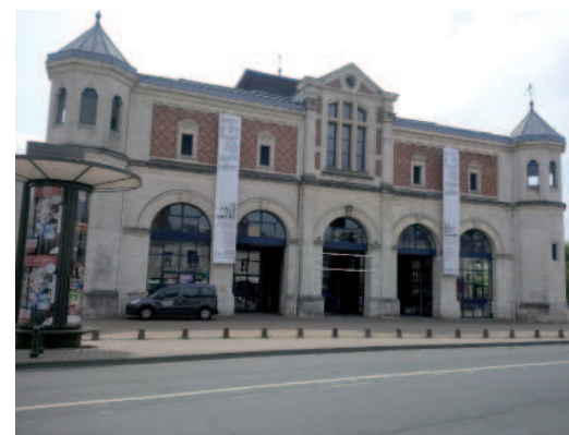
La requalification de l'ancienne Halle aux grains, située dans le centre historique de Blois, en site culturel a permis de conserver la qualité architecturale du bâtiment (© D. Tortet)
