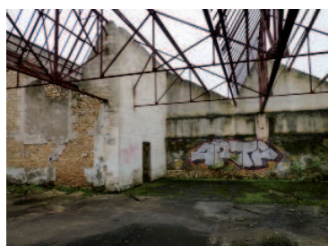
L'ancienne manufacture de draps de Balsan, à Châteauroux, a laissé place à de nombreuses friches. Certains bâtiments ont déjà été réhabilités, d'autres sont en attente de requalification (© G. Janvrot)
