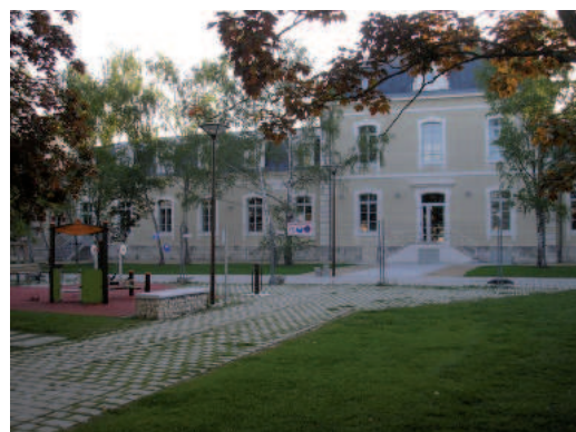
L'éco-quartier Baudens à Bourges, situé sur une ancienne friche militaire, joue la carte de la mixité sociale et fonctionnelle en proposant différents services et logements à proximité du centre-ville (© B. Jargois, Conseil Départemental du Cher)
